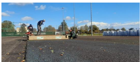
Aus alt mach neu – Einbau der Recycling-Elastikschicht beim FT Starnberg 09.
