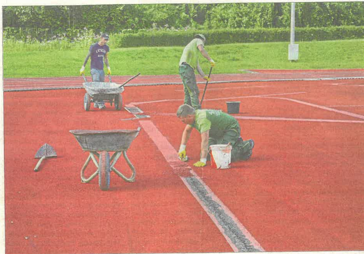
Neuen Synthesekautschuk tragen Mitarbeiter einer Fachfirma über schadhaften Stellen der Tartanbahn auf, ebnet und glätten die Granulatmasse mit breiten Spachteln. – Fotos: Gerlitz
