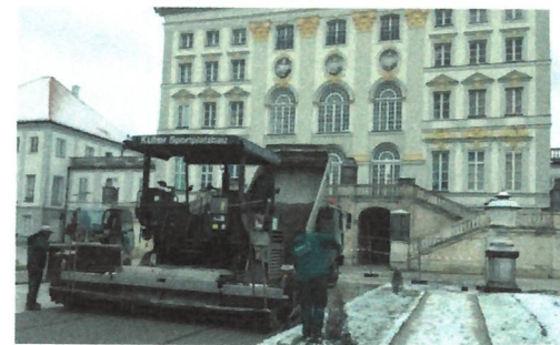
Kutter Sportanlagen- und Landschaftsbau saniert die zentralen Wege und Plätze im Schloßpark Nymphenburg.
